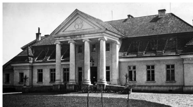
Pałac w Bolszowcach odbudowany przez Kornela Krzeczunowicza
