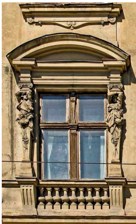
Fragment fasady kamienicy Zybliekiewicza 18, Wikimedia – domena publiczna
